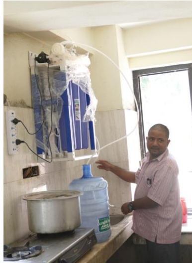
der neue Wasserfilter wird installiert
