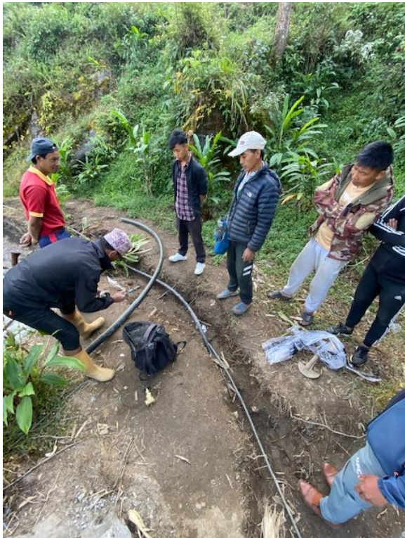
Chumba läuft die Wasserleitungen für die Kontrolle ab, bevor sie vergraben werden.
