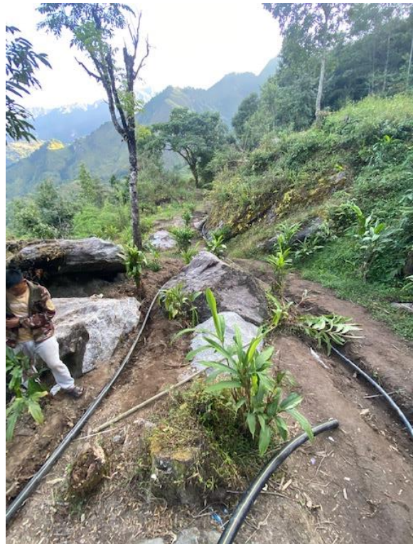
Chumba läuft die Wasserleitungen für die Kontrolle ab, bevor sie vergraben werden.
