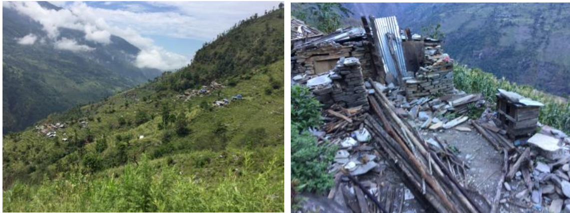
Hawadara und umliegende Dörfer - Nahaufnahme: Zustand fast aller Häuser in den Dörfern
