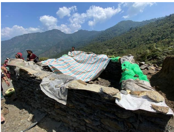
Nun wurde gemauert. Immer, wenn es regnete, musste das Mauerwerk abgedeckt werden.
