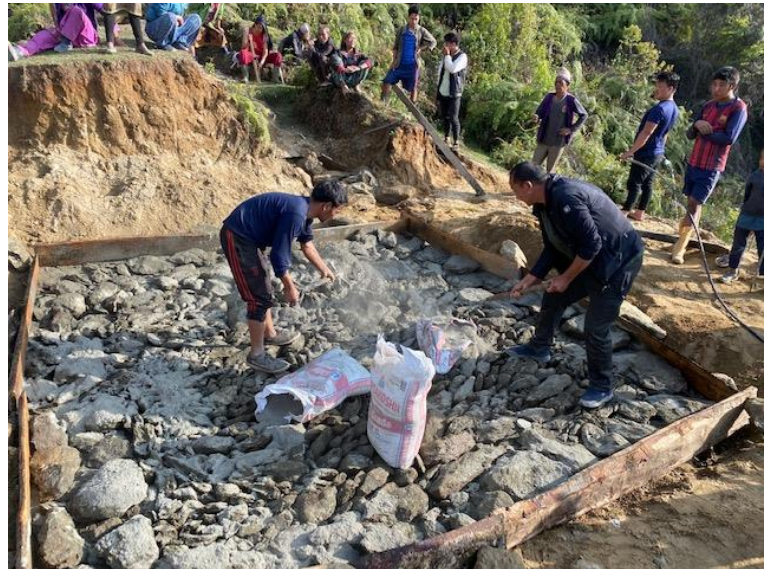
Auf das vorbereitete Fundament wurde trockener Zement gestreut und darüber wurde betoniert.
