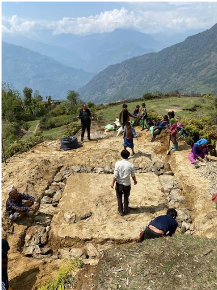
Auf das vorbereitete Fundament wurde trockener Zement gestreut und darüber wurde betoniert.
