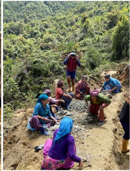
Am Rande der Baustelle saßen die Frauen und hauten Steine für den Beton klein.
