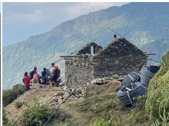
Nun wurde gemauert. Immer, wenn es regnete, musste das Mauerwerk abgedeckt werden.
