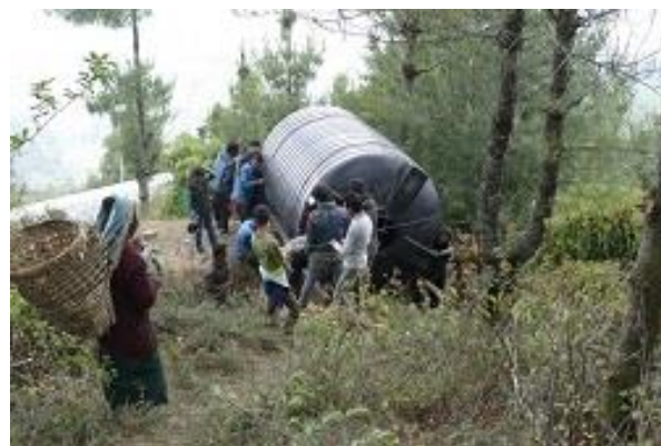
Die vier 10.000 Liter-Tanks werden zu den beiden Mittelstationen gebracht sowie zwei ganz nach oben auf den Berg getragen.
