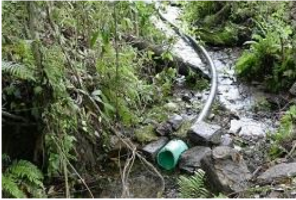
Erfassung der Quelle mit einem einfachen Trichter sowie einem Filter aus Wurzeln
