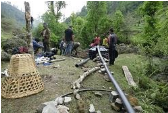
Von der Quelle fließt das Wasser direkt in einen 3.000 Liter-Tank. Von diesem muss das Wasser die 2.700 Meter-Strecke den Berg hochgepumpt werden.
