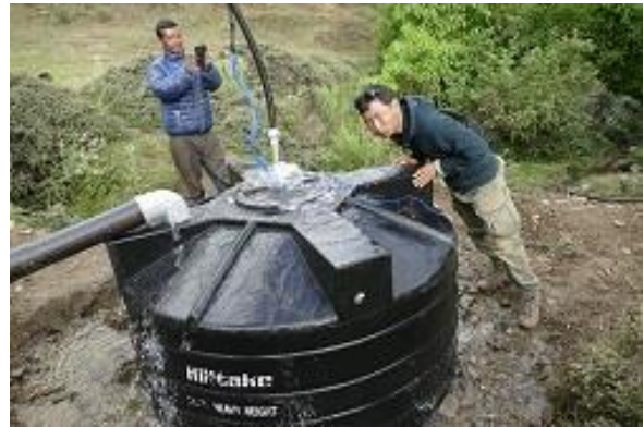
Von der Quelle fließt das Wasser direkt in einen 3.000 Liter-Tank. Von diesem muss das Wasser die 2.700 Meter-Strecke den Berg hochgepumpt werden.
