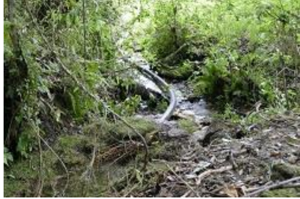
Erfassung der Quelle mit einem einfachen Trichter sowie einem Filter aus Wurzeln
