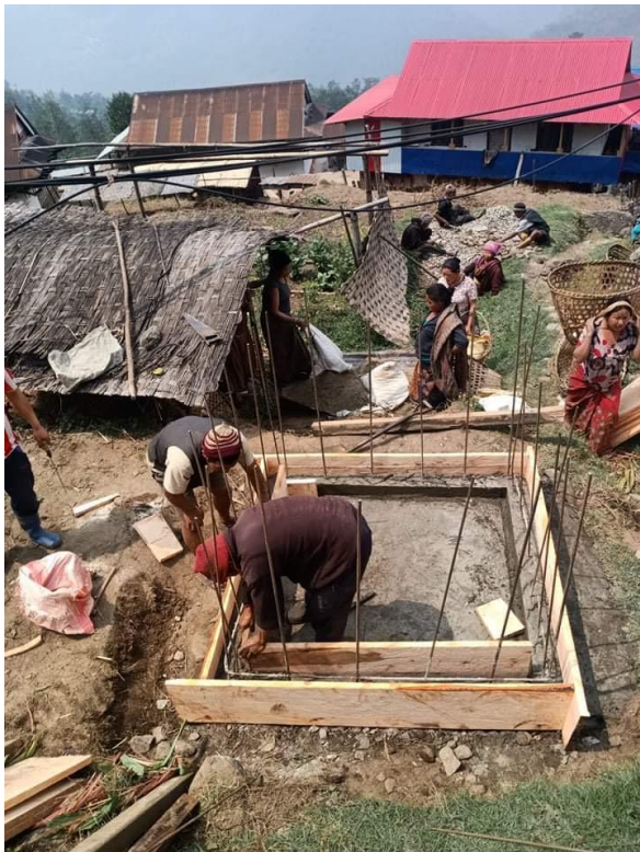
Insgesamt 4 Wassertanks wurden zur Verteilung des Wassers mit direkten Anschlüssen in die Haushalte gebaut.
