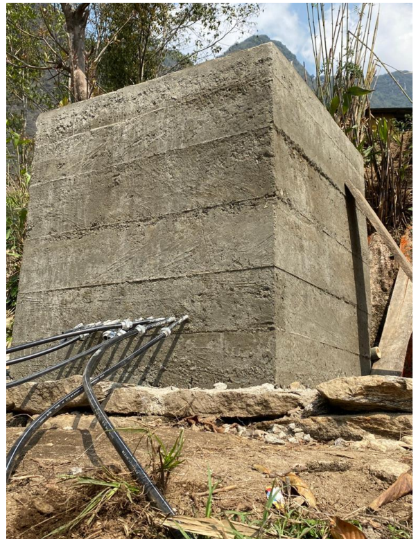
Insgesamt 4 Wassertanks wurden zur Verteilung des Wassers mit direkten Anschlüssen in die Haushalte gebaut.
