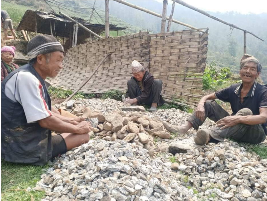
Für den Beton der Wassertanks mussten Steine vor Ort klein geschlagen werden.
