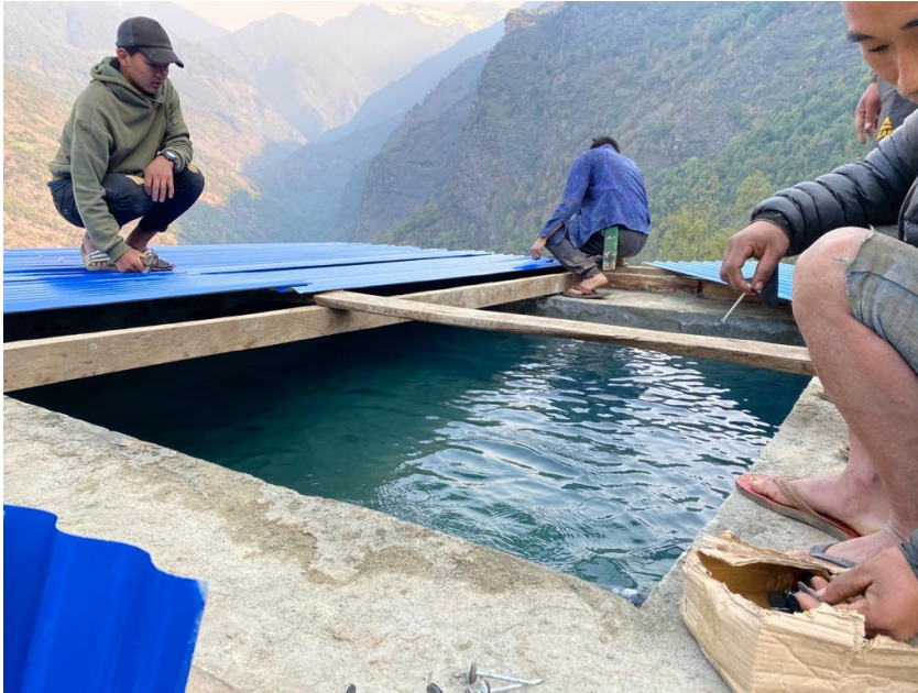
Einer der vier großen Wassertranks mit ca. 90.000 Litern Fassungsvermögen
