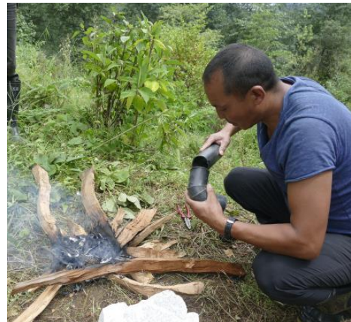
... die Wasserleitungen werden auf Maß geklebt
