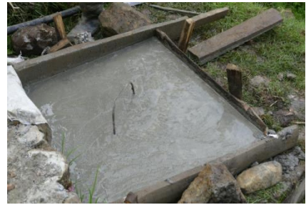
Eine der vier Quellfassungen. Mit Holzschieber zum Wasser stoppen (links) und Filter (Mitte). Ein Deckel für die Fassung wird zementiert (rechts).
