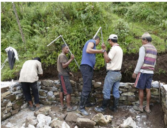
Die Wasserleitungen wurden eingesetzt.
