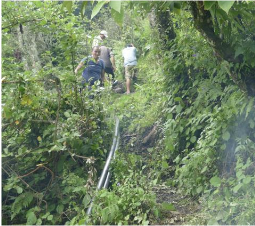
...die Zuflussrohre zum Tank werden gelegt
