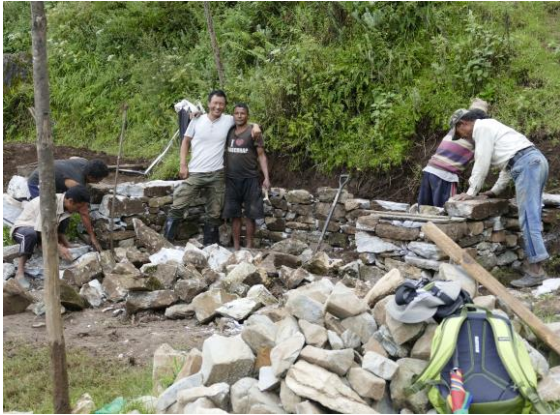
Beginn des Baus der Wasserstelle
