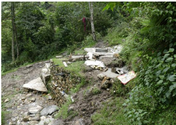
Die Arbeiten an der Quellfassung. Von hier verteilt sich nun Wasser in vier Dörfer.
