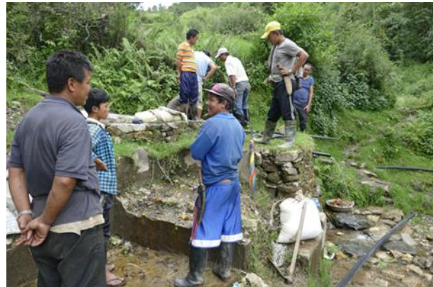
Die Arbeiten an der Quellfassung. Von hier verteilt sich nun Wasser in vier Dörfer.
