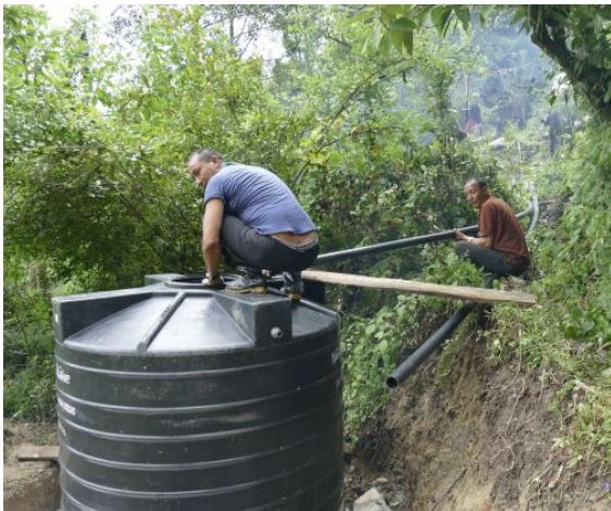
... der Wassertank wird aufgestellt
