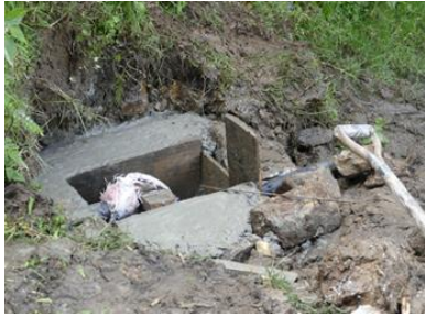
Eine der vier Quellfassungen. Mit Holzschieber zum Wasser stoppen (links) und Filter (Mitte). Ein Deckel für die Fassung wird zementiert (rechts).
