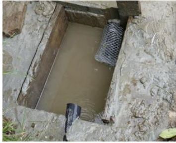
Eine der vier Quellfassungen. Mit Holzschieber zum Wasser stoppen (links) und Filter (Mitte). Ein Deckel für die Fassung wird zementiert (rechts).
