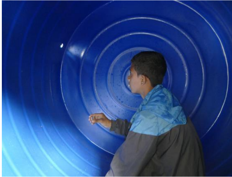
Vorbereitung des Wassertanks. Es wurde unten ein Loch mit Wasserhahn eingesetzt, sodass man den Tank für die regelmäßige Reinigung leerlaufen lassen kann!
